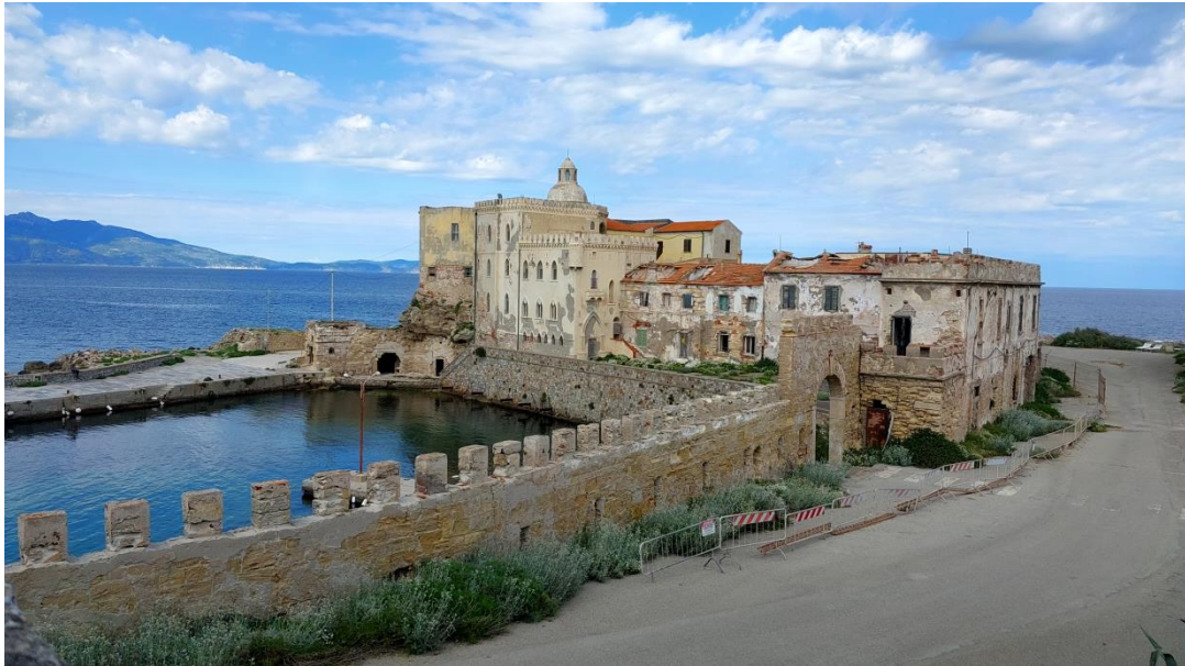
Il porto di Pianosa con il Palazzo della Specola in avanzato degrado
